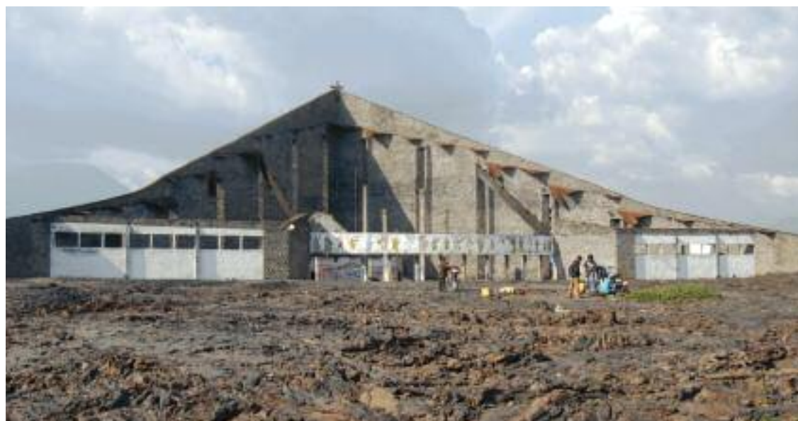
Nur die Rückwand der Kathedrale von Goma hat den Vulkanausbruch von 2002 überstanden.
