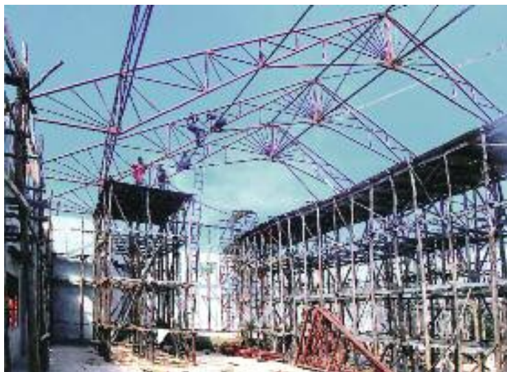
Die Dachkonstruktion der riesigen Versammlungshalle
