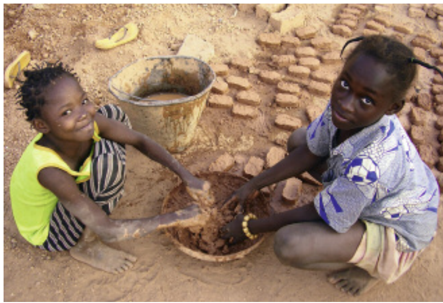
Florence und Edwige kneten den Lehm und formen Bausteine für eine Krippe.
