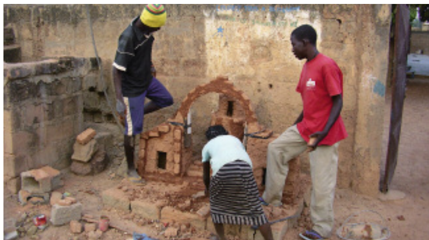
Beim Bau legen Herman, Florence und Aristide gemeinsam Hand an.
