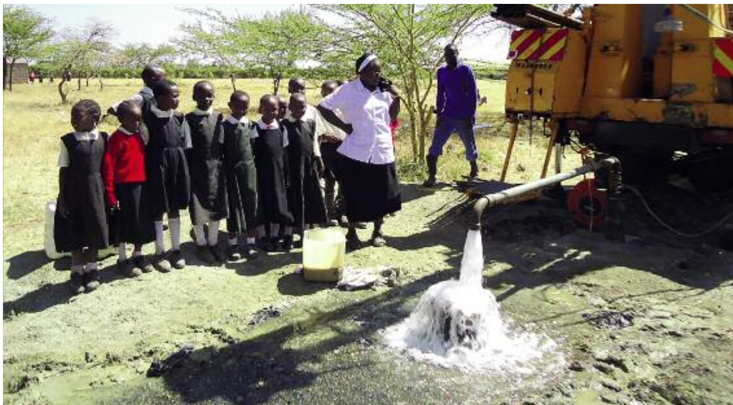
Der Pumpentest überrascht mit einem großartigen Ergebnis: viel Wasser!
