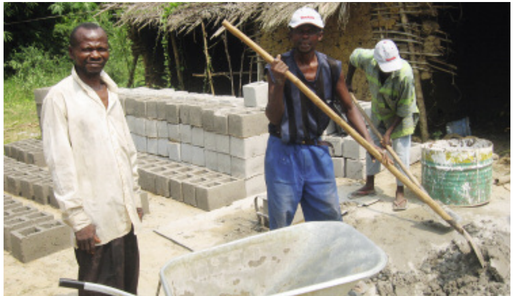
Der Sand kommt aus dem Fluss und der Zement mit dem Schiff aus der Hauptstadt. Die Herstellung der Betonsteine ist harte Arbeit. Tausende davon werden für das neue Pfarrhaus gefertigt.
