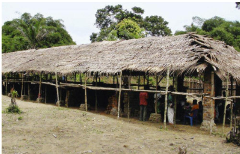
**Fast fertig: Nur noch die Mauern fehlen und das behelfsmäßige Ndele-Dach muss durch Dachplatten ersetzt werden.**
