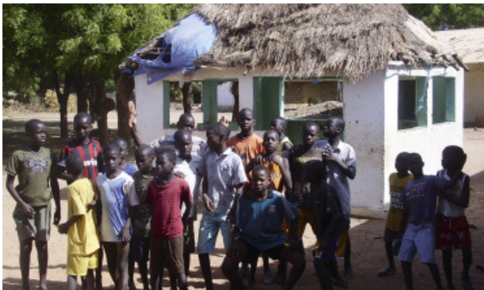
Ein Teil der Internatsschüler. Nicht alle Häuser sind in einem so schlechten Zustand, wie man es hier sieht. Aber alle müssten dringend repariert werden.
