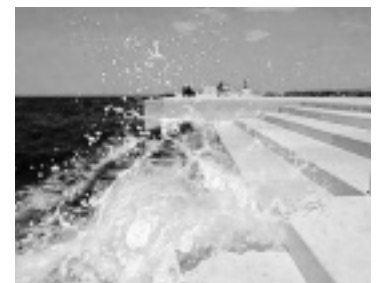
MEERESORDEL 2006 hat der Architekt Nikola Bašić auf einer Länge von 70 Meter unter der Strandpromenade von Zadar 35 Orgelpfeifen horizontal eingelassen. Die Luftöffnungen sind in den Stufenabsätzen.
