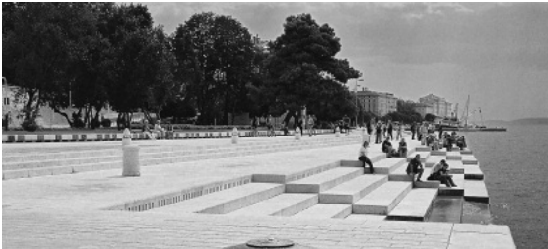
MEERESORDEL 2006 hat der Architekt Nikola Bašić auf einer Länge von 70 Meter unter der Strandpromenade von Zadar 35 Orgelpfeifen horizontal eingelassen. Die Luftöffnungen sind in den Stufenabsätzen.
