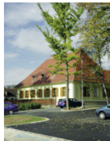
Das renovierte Wohnhaus der spiritanischen Kommunität in Podvinje.
