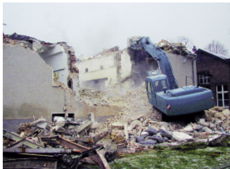
Der Bagger setzt der Backstube ein unwiderrufliches Ende.
