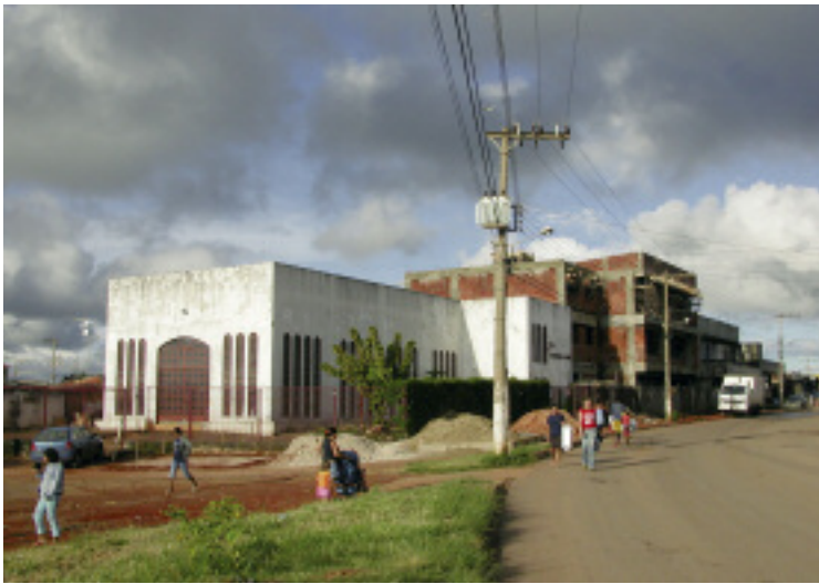
Noch ist die Gemeindezentrum in der Pfarrei St. Franziskus nicht fertiggestellt, aber mit der Hilfe vieler Ehrenamtlicher geht es voran.
