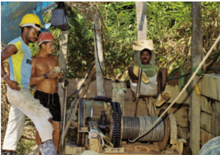
Am Kran: Die Sprengmeister verlassen sich auf Zair.
