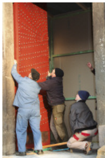
Einbau der großen Holztür im Südportal der Knechtstedener Basilika: Die Restaurierung wurde vom Förderverein finanziert.
