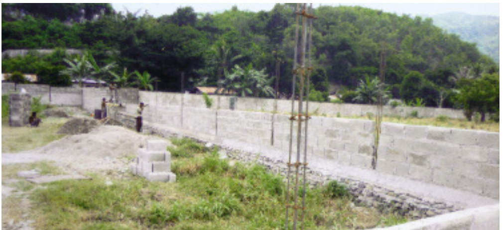
Vor Beginn der Bauarbeiten wird das Gelände mit einer Mauer umgeben, um Diebe fernzuhalten.
